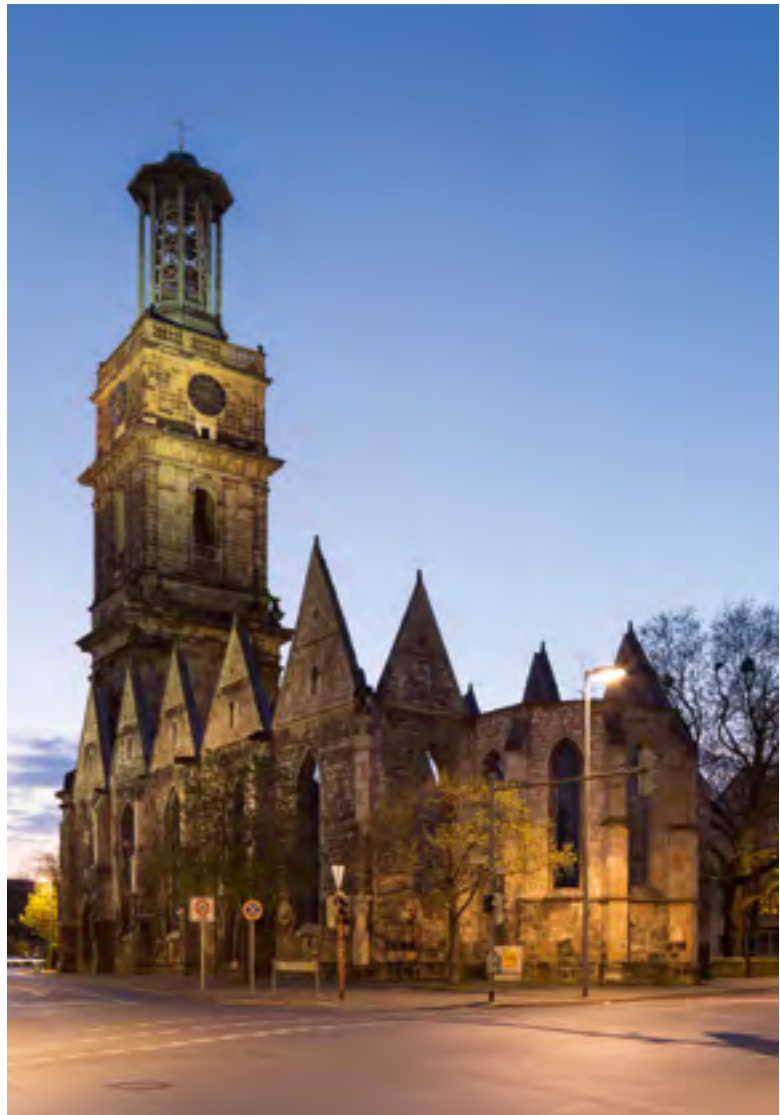
Ruine der Aegidienkirche an der Breiten Straße/Osterstraße in Hannover. © Christian A. Schröder / Wikimedia
