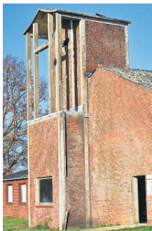
Als Notkirche errichtet, zerfiel der Bau zusehends und wird jetzt renoviert.
