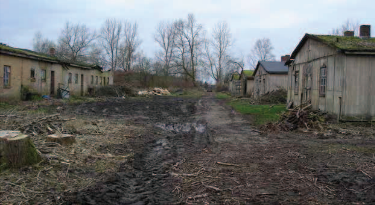
Ansicht eines Teilbereiches des Gedenkstättenengeländes. Erkennbar sind die maroden Baracken. Bei einer ersten Baracke wurde ehrenamtlich das Dach saniert. Foto: Andreas Ehresmann, 2007
